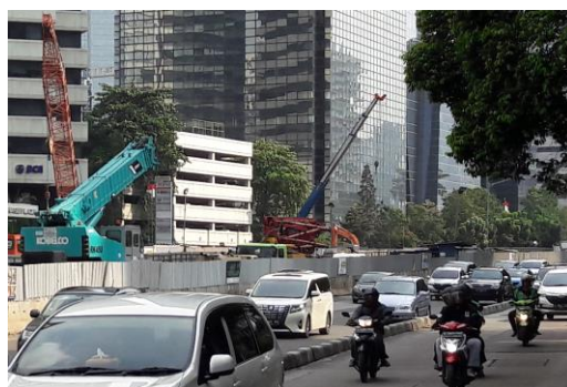
【ジャカルタ市内、LRT工事の様子】
